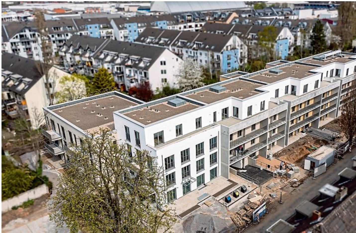
Das aktuelle Bauvorhaben der „Grundstein“ auf der Mannsfelder Straße umfasst 86 Neubauwohnungen.
